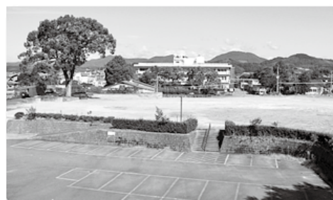
▲建設予定地の既存施設（旧中央公民館、旧勤労青少年ホーム）の解体が終わりました。
