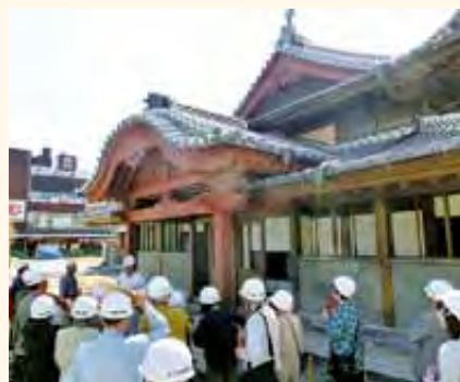
北側玄関の様子
