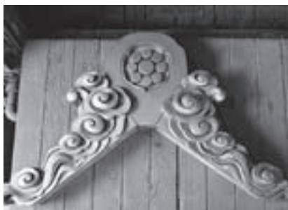
新たに製作した南北大屋根の鬼瓦
